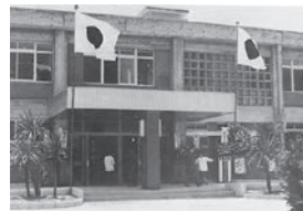
知多厚生病院竣工式
